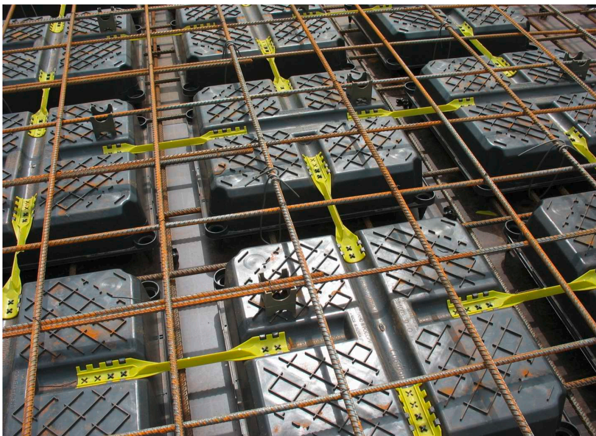
Рис.4.1.5-2 Общий вид несъемной опалубки, установленной на внешней опалубке и смонтированным нижним и верхним армированием плиты (до укладки бетонной смеси)
