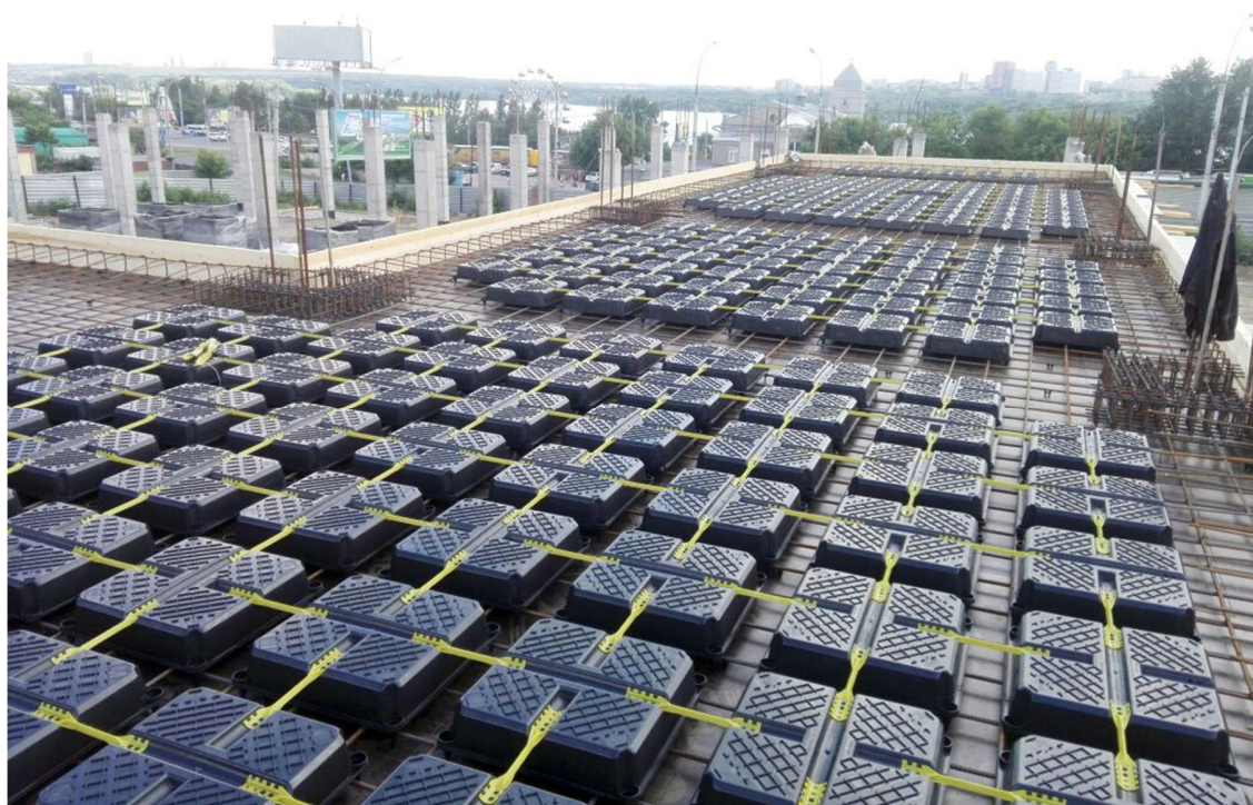
Рис.4.1.5-4 Общий вид установленной несъемной опалубки на объекте строительства
